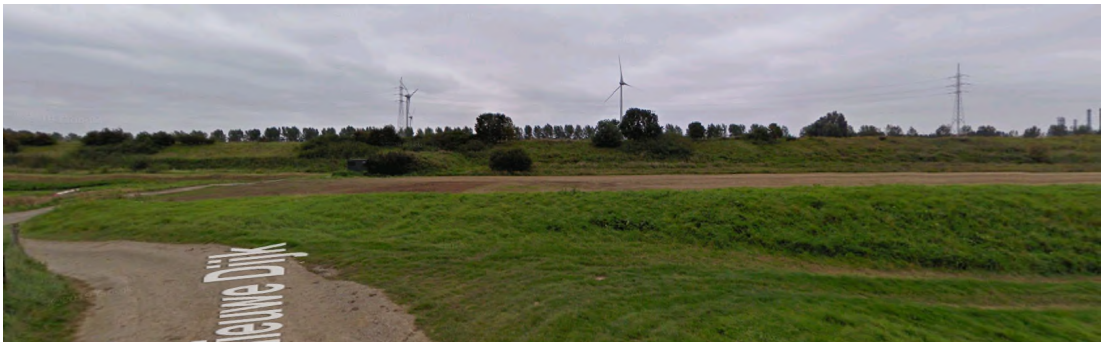
Zicht op de "grensberm" vanaf de Nederlandse zijde (september 2010)
